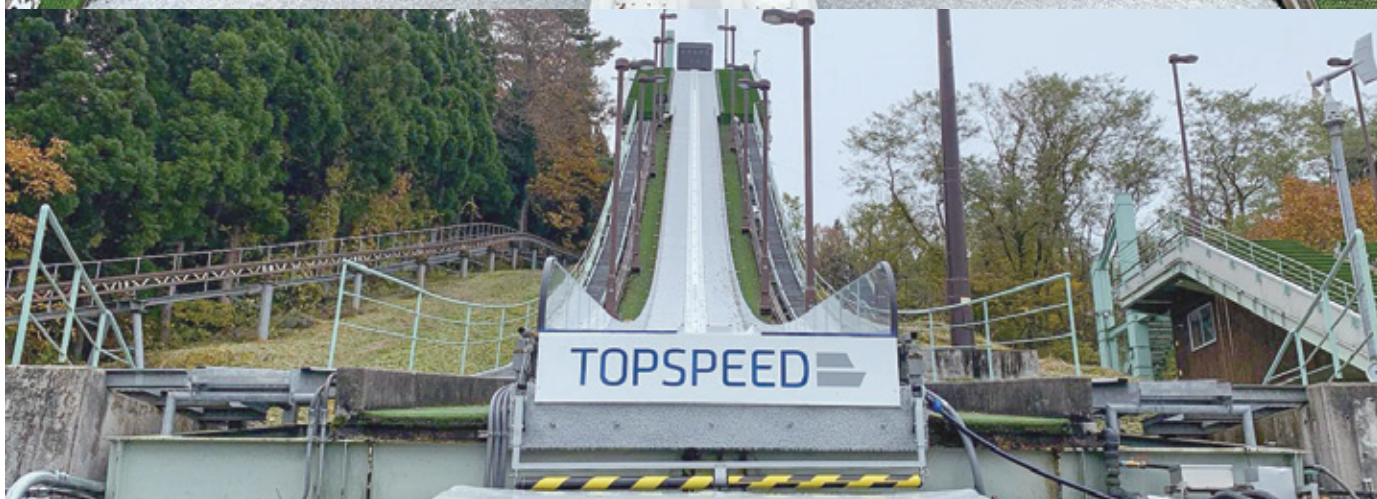
[写真提供：東京美装興業(株)東北支店盛岡営業所鹿角事業所]
